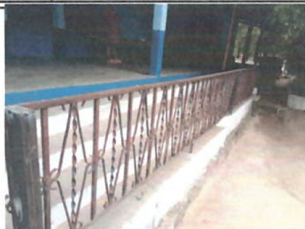
Foto 3: Sustitución de barandales metálicos, incluyendo fijaciones, pintura y soldaduras.
