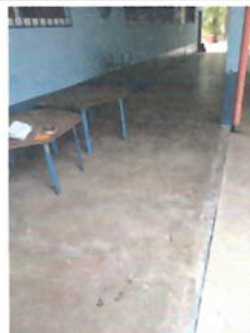
Foto 2: Sustitución de piso de concreto con acabado liso por piso de granito, incluyendo preparación de superficie y nivelación.
